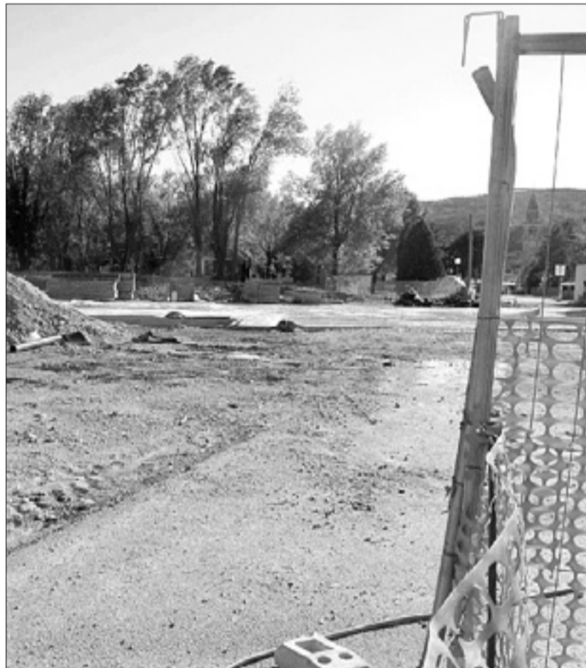
Gradbišče predora v Sovodnjah
